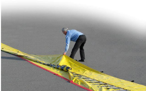
1. Desenrolle completamente la barrera
