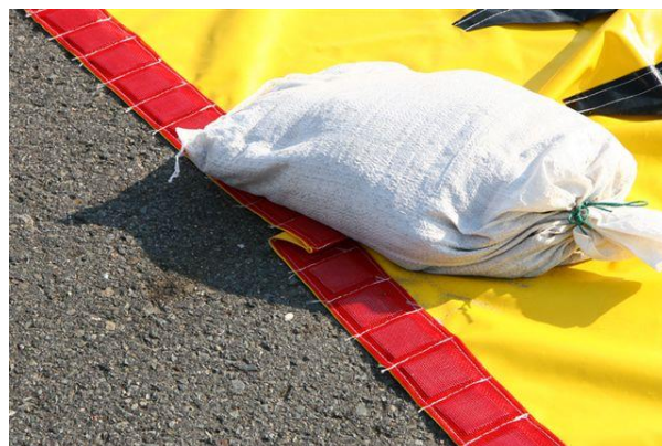
4. También se puede utilizar bolsas de arena para cerrar los espacios formados por las cargas de peso de la barrera
