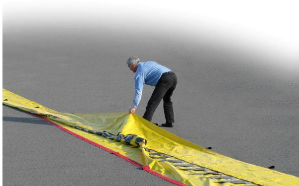
1. Desenrolle completamente la barrera
